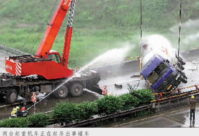
两台起重车正在起吊出事罐车
