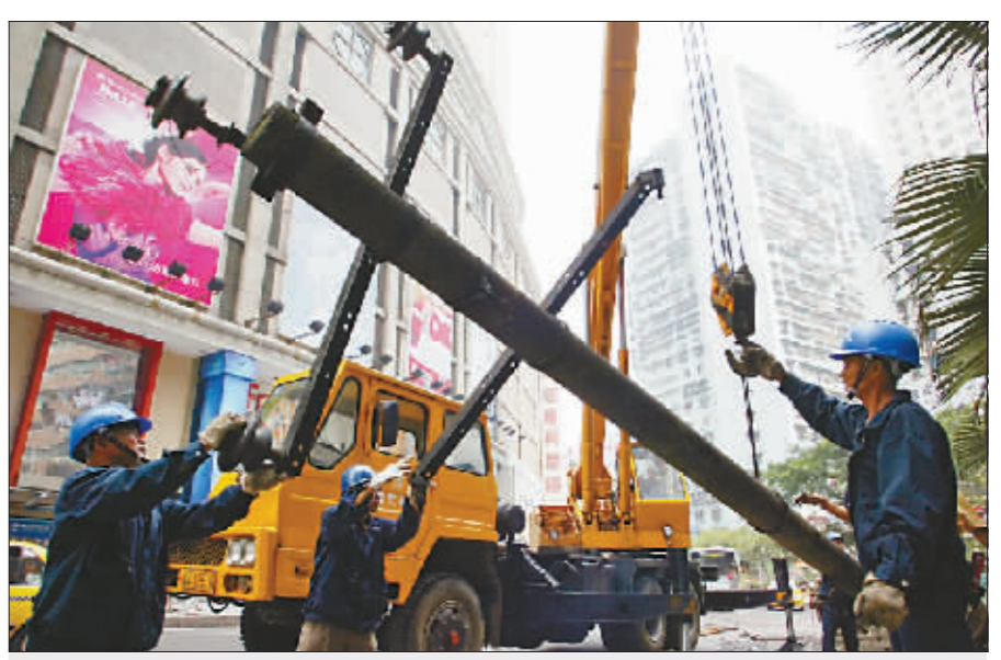
临江路支路上最后一根电杆被电力工人拆除
