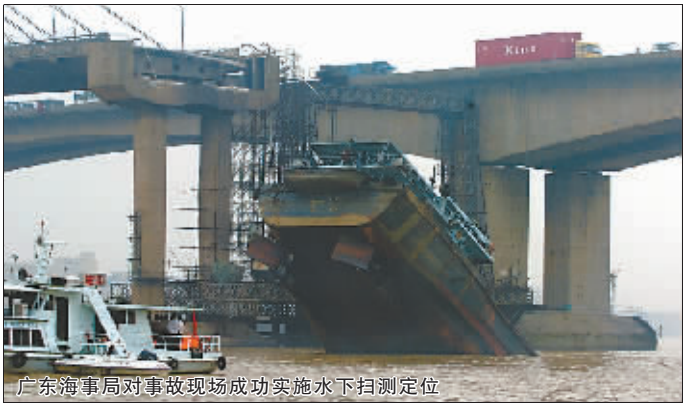
广东海事局对事故现场成功实施水下探测定位
