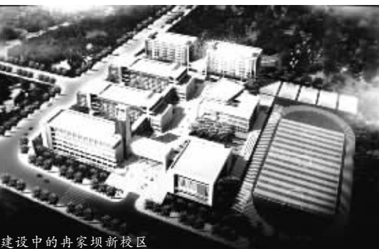
建设中的冉家坝新校区
