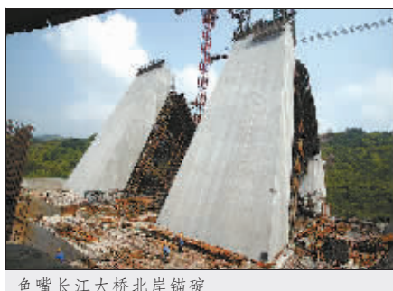
鱼嘴长江大桥北岸锚碇
