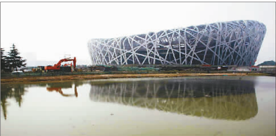
日前，2008年北京奥运会国家体育场“鸟巢”南侧人工蓄水池正式试水。据悉，“鸟巢”共有雨水贮水池六座，一次最多可容纳一万二千立方米的雨水，平均每年回收雨水约六万七千立方米，经处理后供水量约五万立方米。
