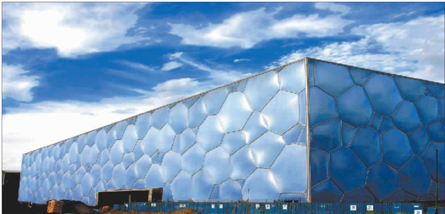
水立方的主体工程已完工，进入内饰安装阶段。
