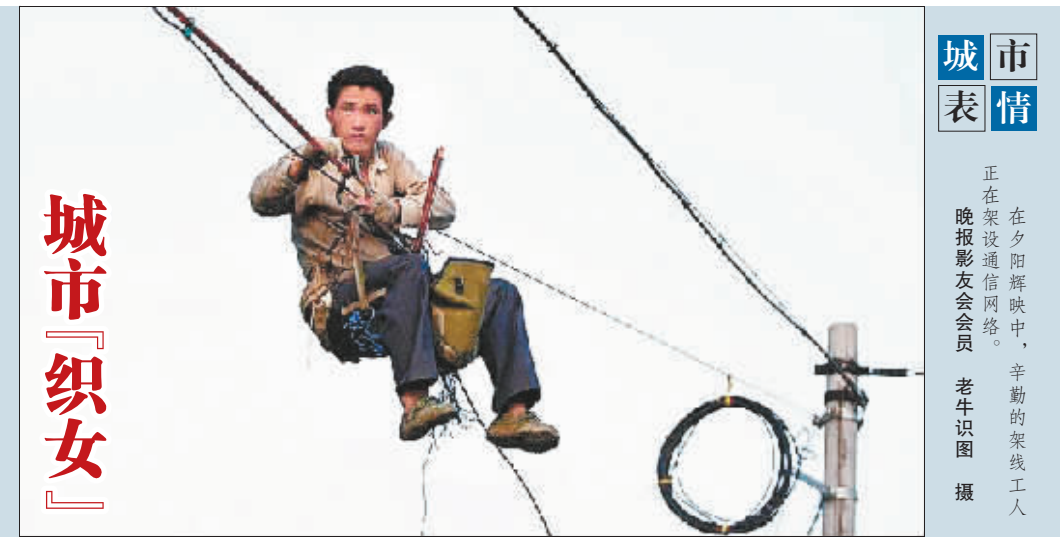
城市「织女」 正在架设通信网络。辛勤的架线工人
