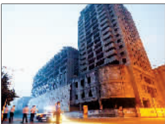
米兰大厦爆破前
