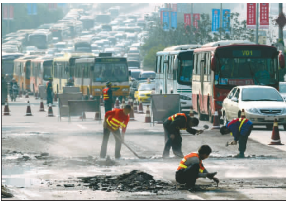
桥面施工宽度减半,造成南桥头大量车辆拥堵。
