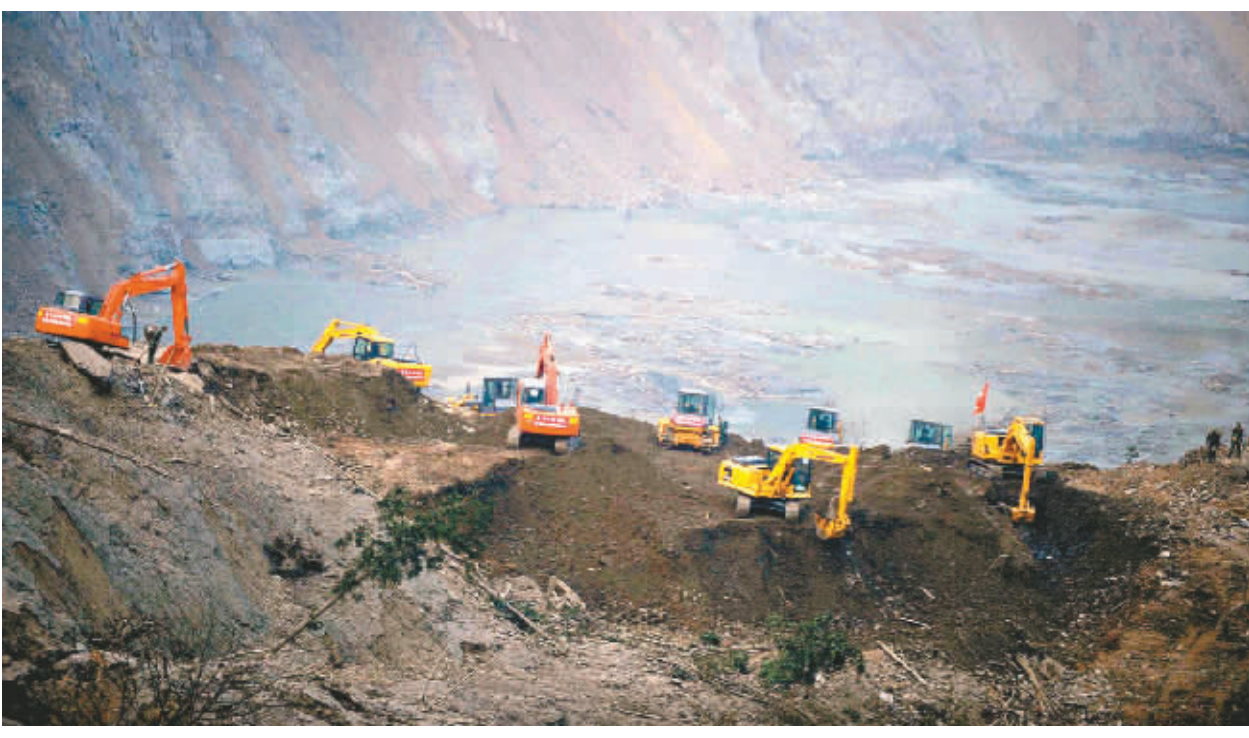
抢险队伍加紧挖泄流槽
