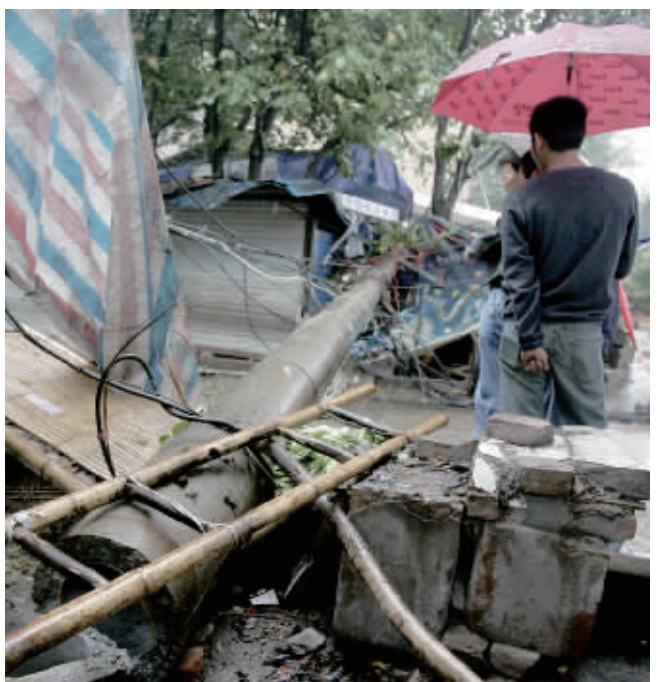
电杆倒在公路中
