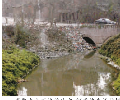
离取水点不远的地方，河道被生活垃圾堵塞。
