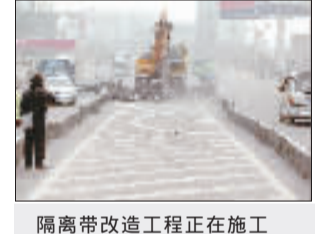
隔离带改造工程正在施工
