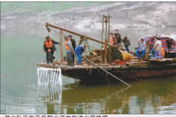
潜水队正在吊装取水深井的进水管格栅
